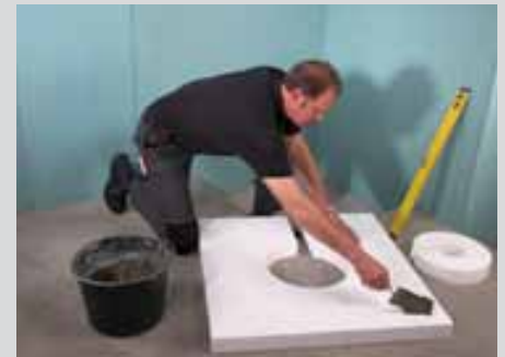
3. Sockel ausgießen oder alternativ Unterbauelement mit vorbereiteter Aussparung einsetzen.
