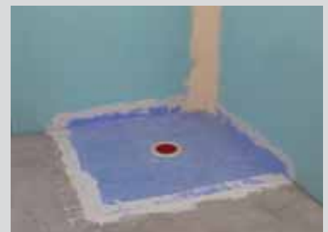
6. Fertig zum Verfliesen.
