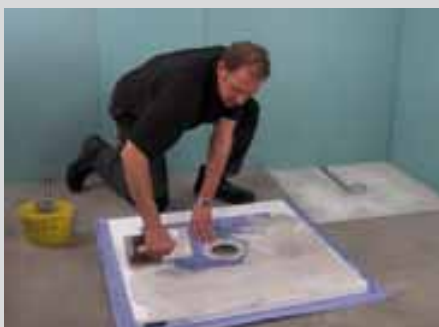
4. Bodenelement vollflächig mit Kleber versehen und einsetzen.
